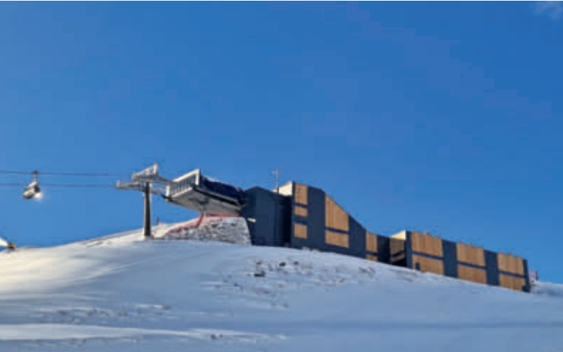
Die neue Mitterlegerbahn ging rechtzeitig zum Saisonstart 2023/24 in Betrieb.
