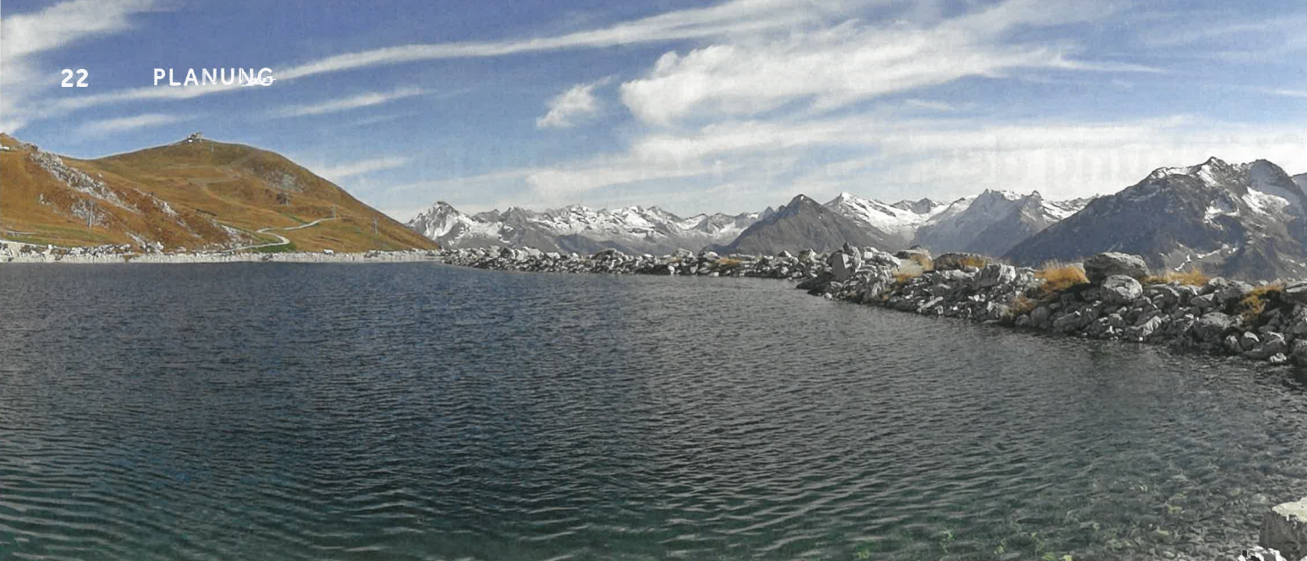
Speicherteich Rastkogel der Zillertaler Gletscherbahn in Tux
