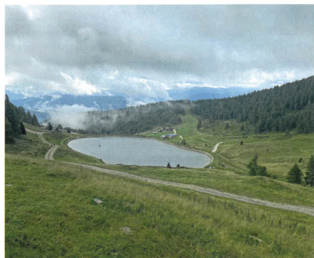
Speicherteich für die Trogalmbahn in Mauterndorf in Salzburg
